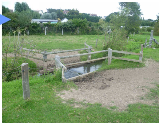
Après travaux n+1
