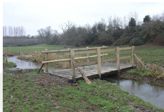
Franchissement passerelle (1200 € HT)
